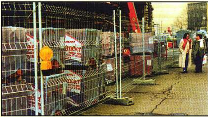
Sicherung von Fußgängern zur Baustelle und zum Kraftverkehr
